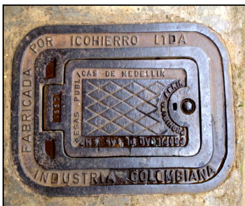
Figura 8. Contador de agua EPM barrio San José La Cima II, 2011. O. G. Anderson
