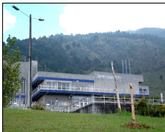
Figura 30. Planta de tratamiento de agua “La Montaña” De EPM María Cano-Carambolas Dic. 2011
